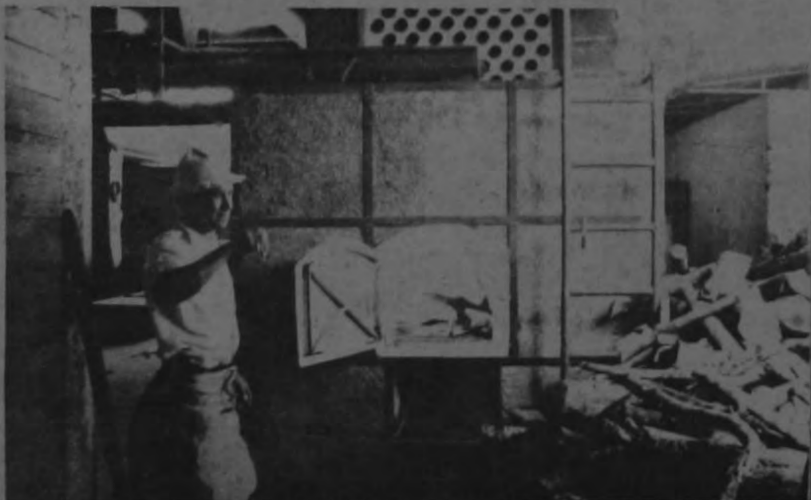
Horno grande para siete secadoras de café, totalmente construido en el país.
