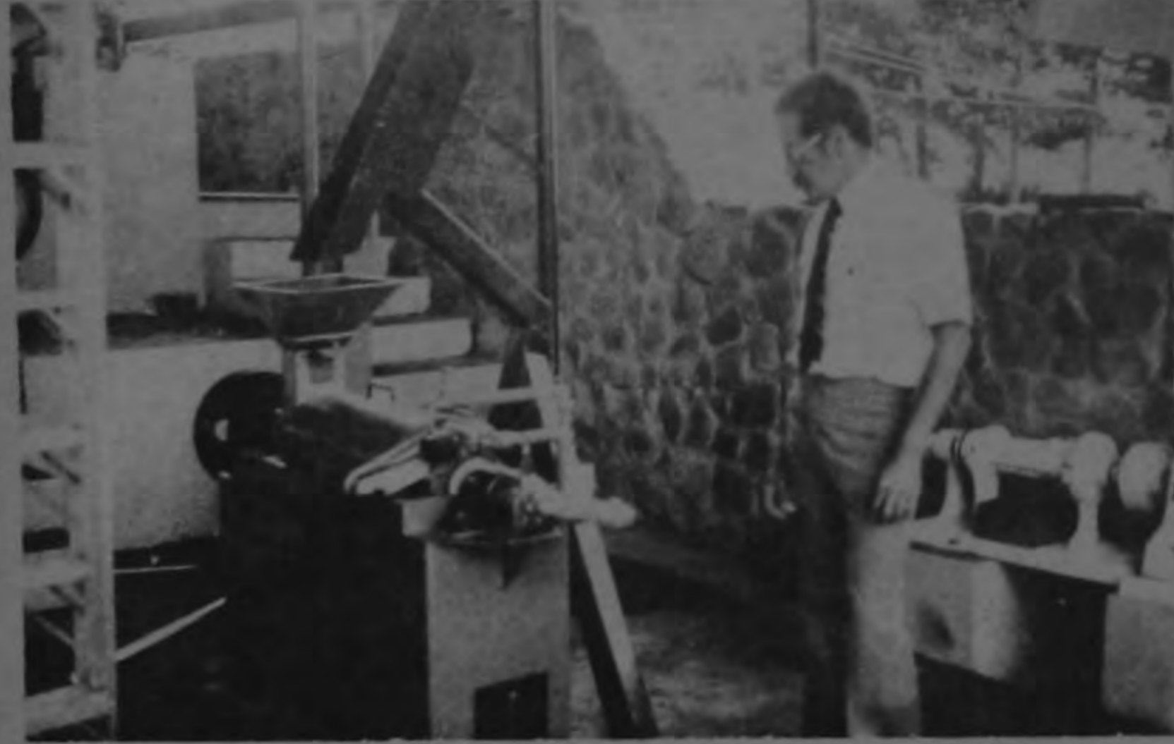
Máquina Aqua-Pulpa para achancar café o desmucilaginar en el proceso húmedo, beneficio experimental en San Pedro de Barva de Heredia.
